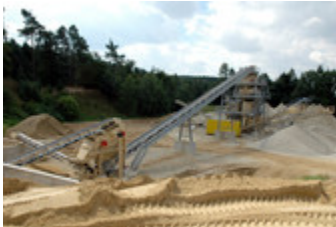
Installations de préparation de gravier et de ballast
